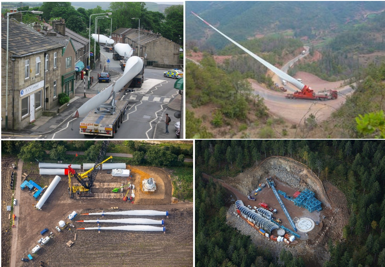
Slika 7: Prevoz sestavnih delov vetrnih agregatov in gradbišče ob stojšču 1 .
