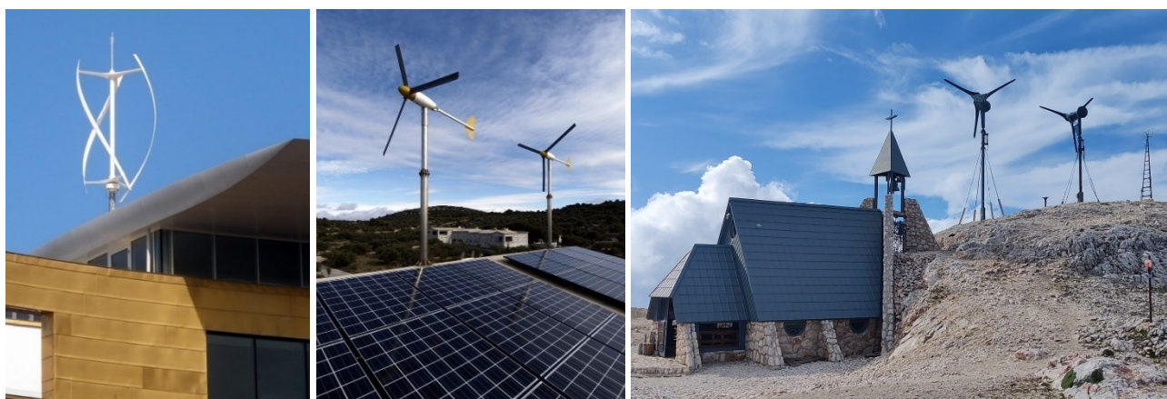
Slika 5: Mikro in male vetrne elektrarne.
